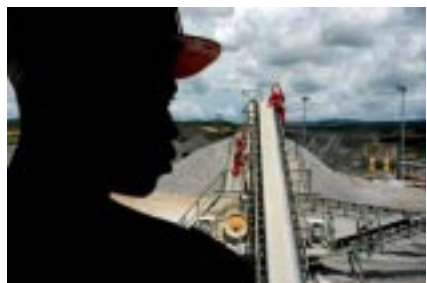
© Fabio De Benedettis Operai alla macchina di frantumazione nel cantiere di Gurara, Stato di Kaduna, Nigeria
